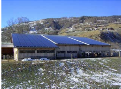
Photovoltaikanlage Peider Michael, Donat
