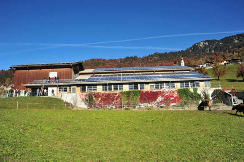
Photovoltaikanlage Sutter Fanas
